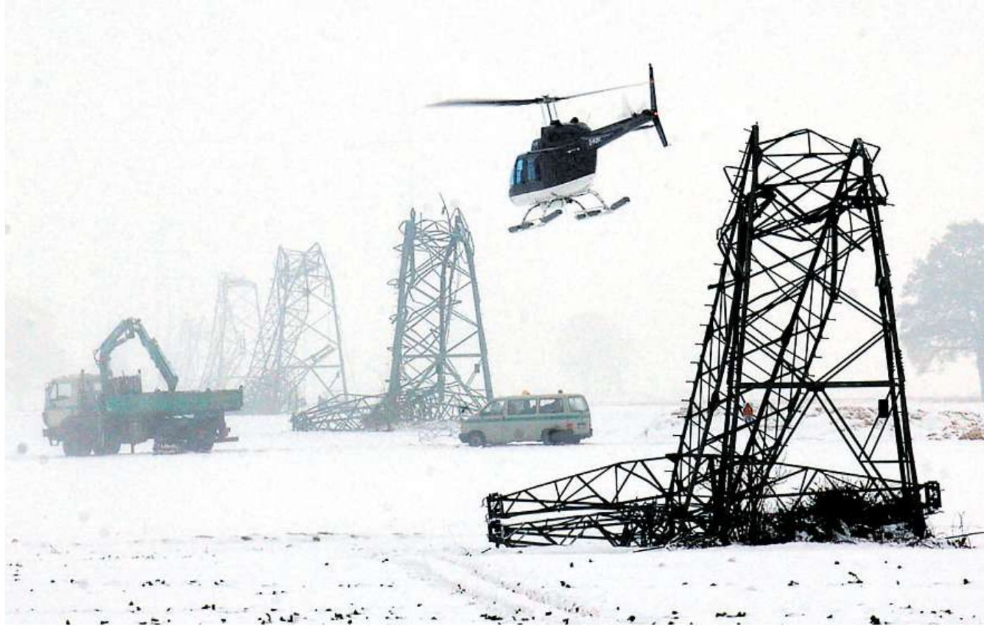
Umgeknickte Strommasten auf einem Feld bei Laer in der Nähe von Münster: 50 Hochspannungsmasten waren 2005 im Münsterland nach starken Schneefällen eingeknickt oder nicht mehr funktionstüchtig.
